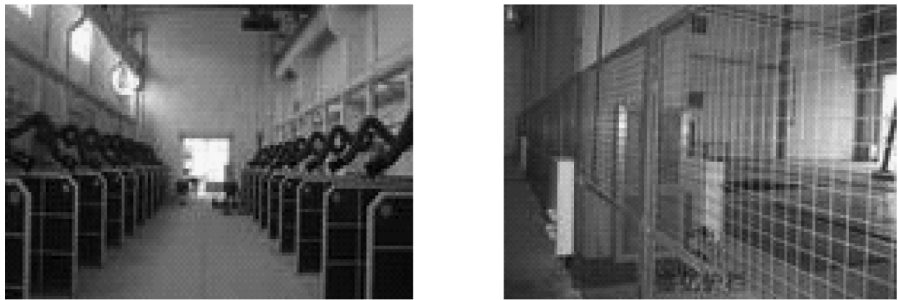
图 4-2 焊接车间安全隔离网
