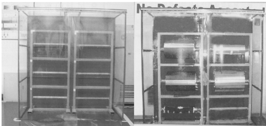
图 9-13 现场防尘措施
