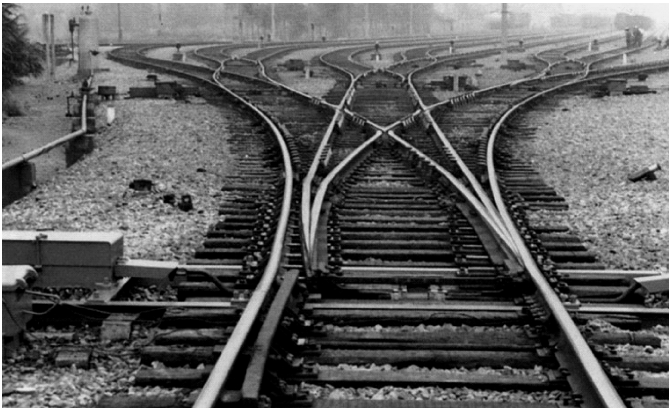
图 1-14 三开道岔实物
