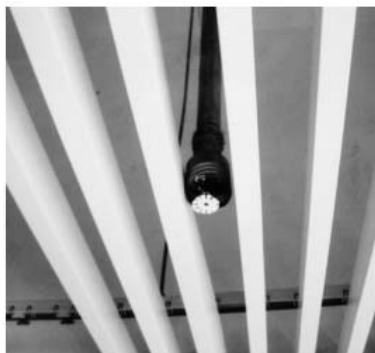
图 2 隐蔽式喷头安装在格栅条之间
