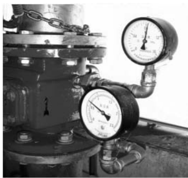
图 1 湿式报警阀组安装
