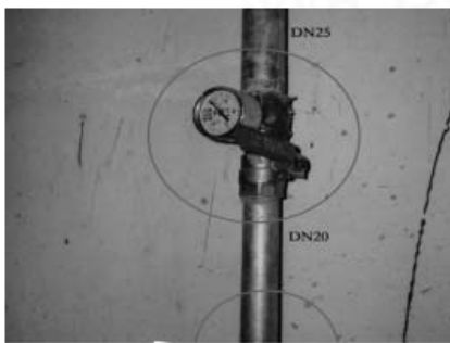
图 5 系统的末端试水装置
