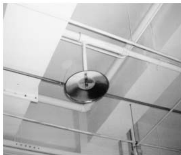
图 3 集热罩与顶棚超距
