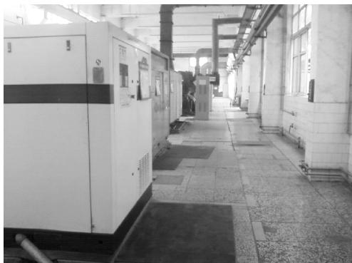
图 2-4 空压机放置不要紧贴墙面,留出通风、检修空间
