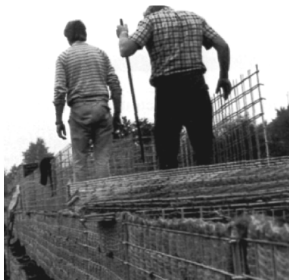
图 12-9 “篮筐结构”是万能的，它们可以用于隔声、边坡加固、河岸护堤；热浸镀锌钢笼具有满足要求的稳定性，同时这些钢笼的空隙处可以填充土壤和植被
