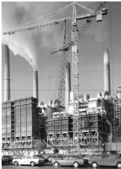
图 12-25 采用了热浸镀锌钢构件的 Düsseldorf 大型发电厂的烟气过滤装置
