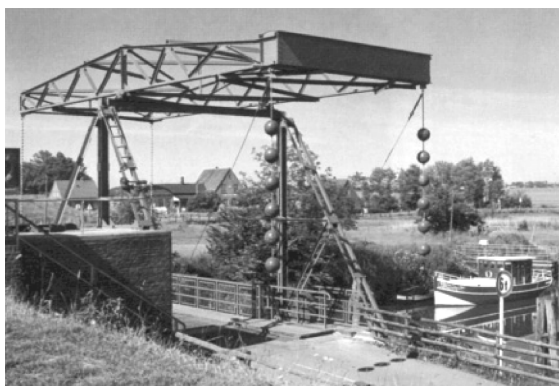
图 12-36 Schleswig – holstein Steinburg Kasenort 的钢铁 开合大桥，重建时采用了热浸镀锌防腐
