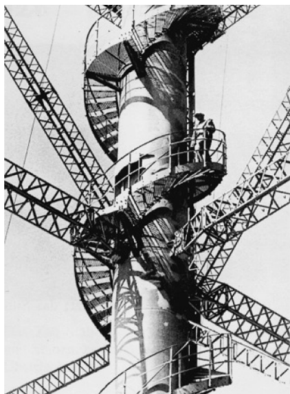
图 12-26 Stade ( Unterelbe ) 的热浸镀锌高压铁塔, 高 227m, 为安全起见, 其表面又进行了涂装处理
