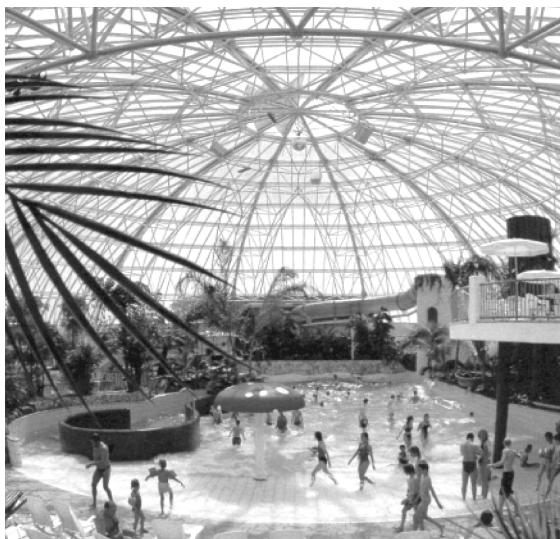
图 12-17 Bremen 新游泳馆的圆形屋顶（直径为 50m，高 18m），它由环形主结构和分散组装件组成，全部采用热浸镀锌 + 白色涂装设计
