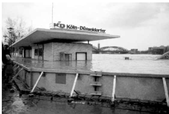
图 12-8 用热浸镀锌钢构件做的移动防洪墙（使 Clologne 的一个老城幸免于莱茵河的洪涝），1988 年这个移动防洪体系通过了实践检验
