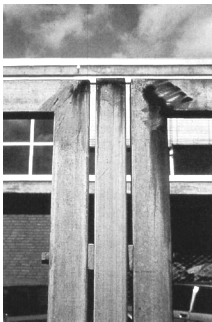
图 7-25 热浸镀锌防护栏结构焊缝位置镀锌层的不正确修复造成的腐蚀
