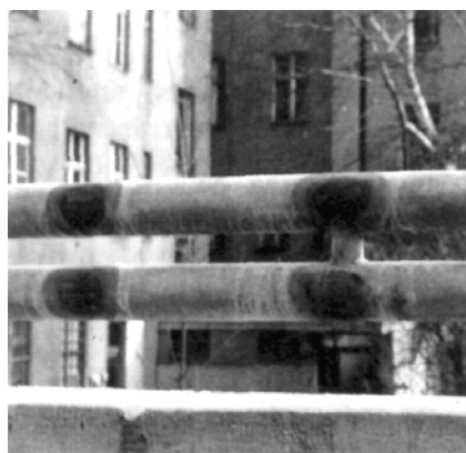
图 7-35 对热浸镀锌栏杆进行火焰矫正造成的镀锌层损坏
