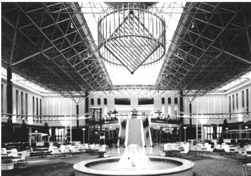
图 12-3 位于展览大厅和参观者通道交叉位置的科隆游乐场的“奥斯广场”，按最高标准进行了顶部装饰，屋顶采用热浸镀锌钢进行空间结构设计
