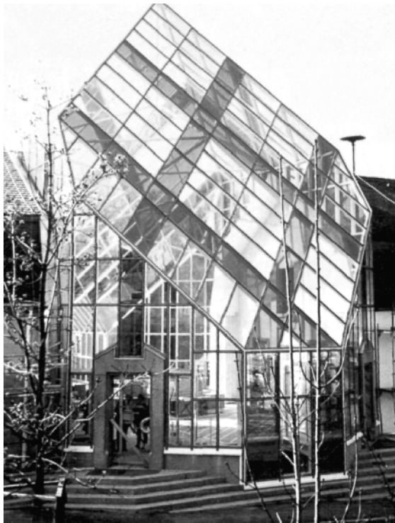
图 12-4 巴德新城法兰克福市疗养中心的现代化钢/玻璃结构，给原来狭窄的老建筑增添了空间
