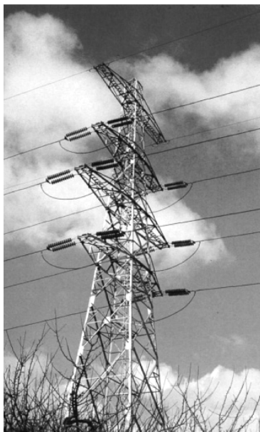
图 12-24 用于电力供给的热浸镀锌铁塔和高压架空线缆
