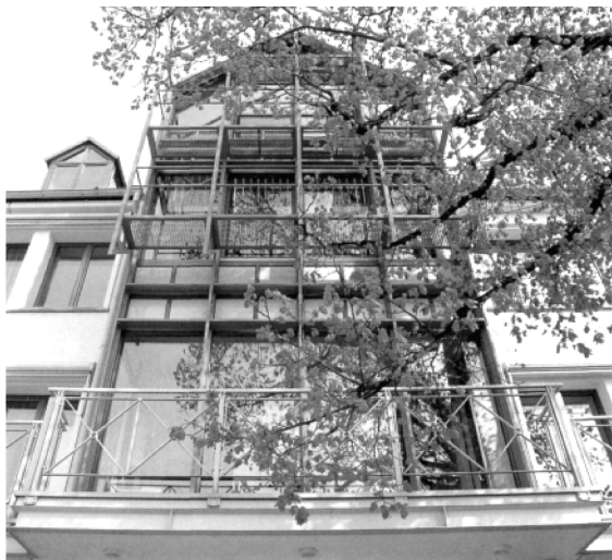
图 12-2 代特莫尔德附近的奥古斯多夫市政大厅门面，由经过热浸镀锌处理的钢结构和玻璃组成，门面部件在厂内进行预处理、热浸镀锌处理和蓝绿色涂装
