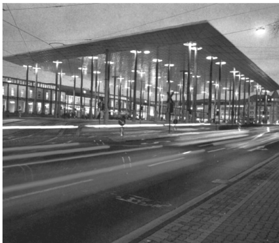
图 12-11 Kassel - Wilhelmshöhe 的新 ICE 火车站，平台区和前面屋顶伸出部分采用热浸镀锌钢结构
