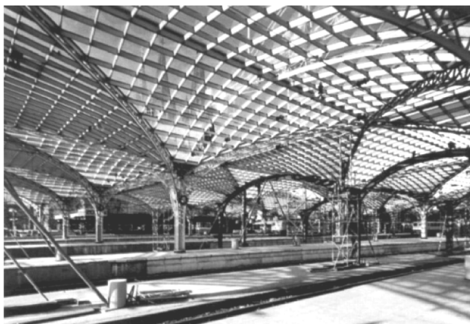
图 12-13 扩建后的 Cologne 中心车站，不仅车站的地标主楼，就连东区的平台也采用了热浸镀锌网状钢结构设计，图片映衬出了主楼的整个轮廓
