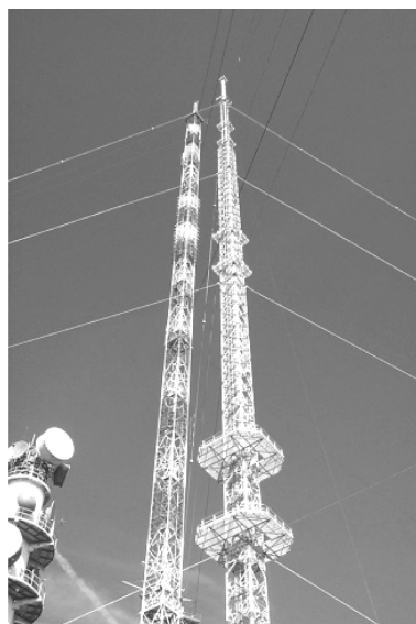
图 12-27 Thales 广播传媒公司的无线信号塔桅杆, 采用热浸镀锌 + 红白色的丙烯酸聚氯乙烯基涂料涂装
