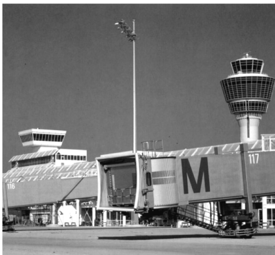
图 12-10 慕尼黑新机场的登机廊桥采用了经过热浸镀锌处理和表面涂装的钢结构，图中塔的前面为直线式分布的长 1010m 的航站楼，航站楼的正面为热浸镀锌加涂层的钢/玻璃结构
