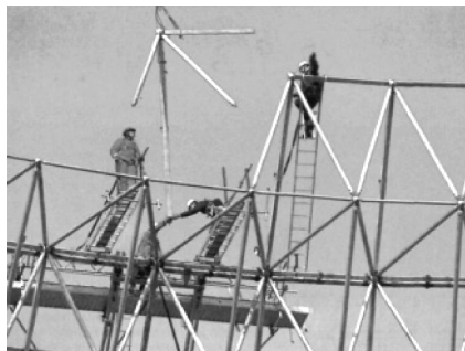
图 12-33 由热浸镀锌连接杆和节点组成的结构系统用于空间结构的建造
