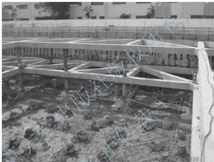
图 2.10 桩与筏形基础组合地基
