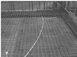
(a) 现浇钢筋混凝土楼板
