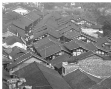
(a) 传统民居坡屋顶
