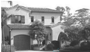
(b) 现代别墅坡屋顶
