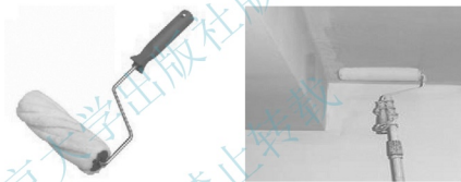
图3.56 涂料施工
