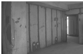
(f) 板材隔墙施工
