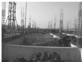
图 2.20 柱下条形基础
