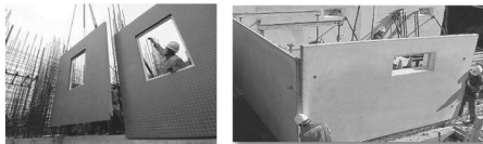
图 0.26 日本工业化住宅预制墙体及施工
