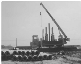
图 2.28 静力压桩施工
