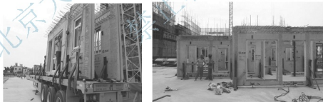
图 0.27 广州万科府前一号工业化住宅墙体施工
