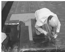
图 2.29 地下室防水工程实例
