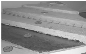
1—钢筋混凝土屋面板；2—卷材防水层； 3—挤塑聚苯板保温层；4—细石混凝土层； 5—水泥砂浆找平层；6—陶瓷地砖饰面
