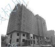
图 3.7 现浇钢筋混凝土墙
