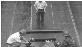
(b) SBS 改性沥青防水卷材施工
