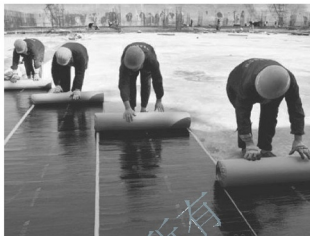
(b) 冷粘法施工
