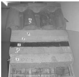
1—钢筋混凝土屋面板；2—水泥砂浆找平层； 3—卷材防水层；4—砂浆保护层； 5—挤塑聚苯板保温层；6—屋面瓦
