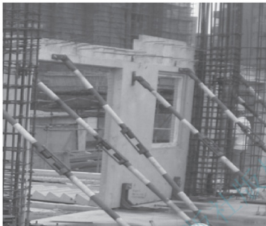
(b) PC外墙斜撑现场图
