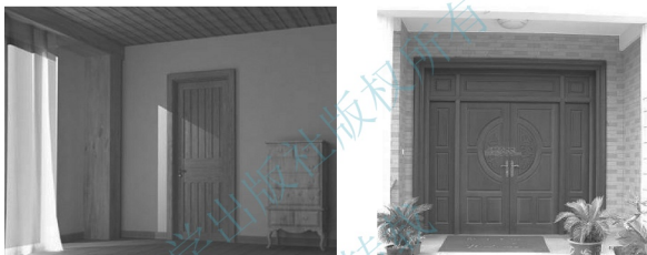
图 7.2 某住宅采用平开木门
