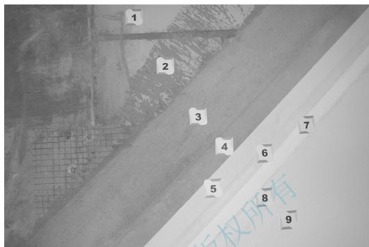
1—加气混凝土砌块墙体；2—甩毛；3—水泥砂浆底层；4—水泥砂浆面层； 5—内墙腻子第一道；6—内墙腻子第二道；7—底漆； 8—内墙面漆第一道；9—内墙面漆第二道
