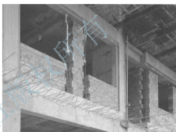
图 3.4 框架结构的墙体
