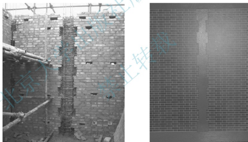
图 3.39 构造柱中的马牙槎
