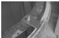
(c) 石材开槽, 用连接件固定
