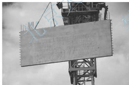
图 3.8 预制混凝土大板墙
