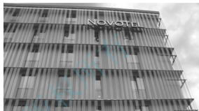
图 7.28 德国某公共建筑玻璃遮阳板
