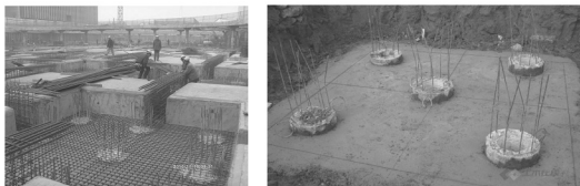
图 2.24 钢筋混凝土承台
