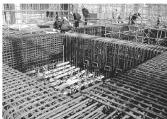
图 0.22 现浇钢筋混凝土结构施工
