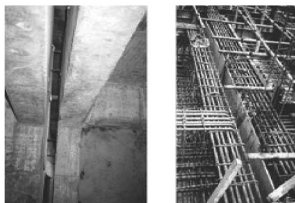
图 8.1 变形缝
