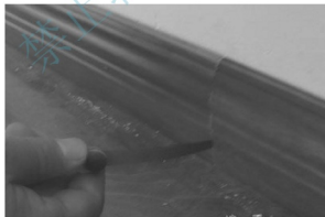
(e) 安装踢脚线
