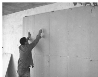
图 3.15 挤塑 XPS 保温板
