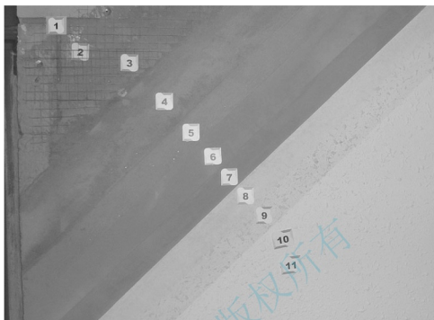
1—加气混凝土砌块墙体；2—甩毛；3—满挂铁丝网；4—水泥砂浆底层；5—水泥砂浆面层； 6—外墙腻子第一道；7—外墙腻子第二道；8—底漆；9—喷点；10—外墙面漆第一道；11—外墙面漆第二道
