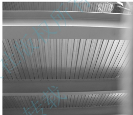
(d) 压型钢板组合楼板
