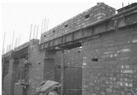
图 3.3 砌体结构的墙体
