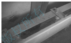
(d) 连接件与石材间填满石材胶
