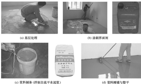
图 4.36 自流平地面施工
