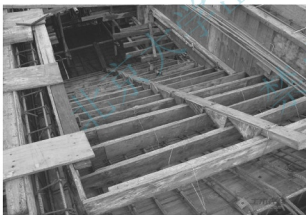
(a) 楼梯的模板和钢筋
