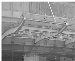
(a) 某办公楼入口处雨篷
