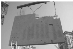
图 0.23 预制装配式建筑施工
