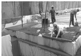
(b) 保护层施工
