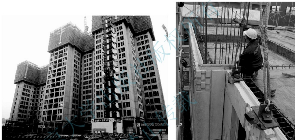
图 10.1 主体结构现浇、墙体预制装配
