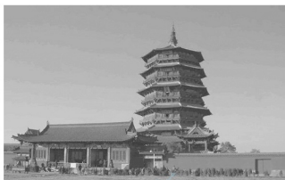
图 0.10 山西应县木塔
