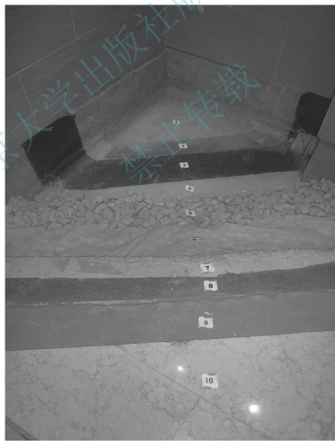
图 4.37 某住宅建筑下沉式卫生间构造做法
