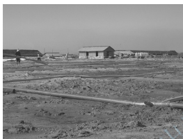
(b) 铺设主支滤排水管
