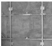
(a) 直骨架制作安装
