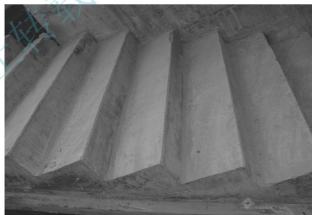
(b) 已拆模板的楼梯梯段
