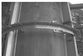
(b) 圆形骨架制作安装
