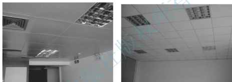
(b) 某办公楼吊顶
