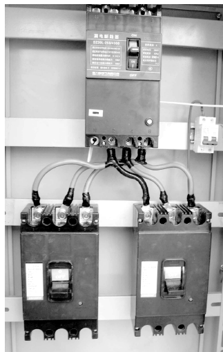
图 1-5 接线端子上应包缠绝缘胶带
