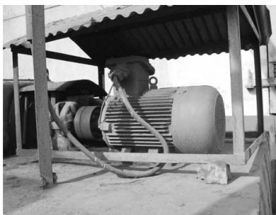
图 2-31 室外电动机应加防雨防晒棚
