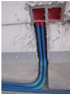
图 1-14 弱电线管开槽
