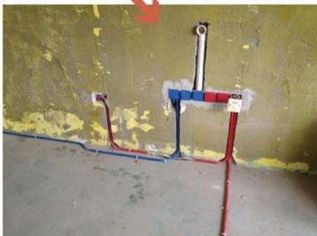
图 1-29 弱电插座的高度图例
