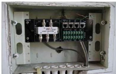
图 1-4 家居弱电箱图例
