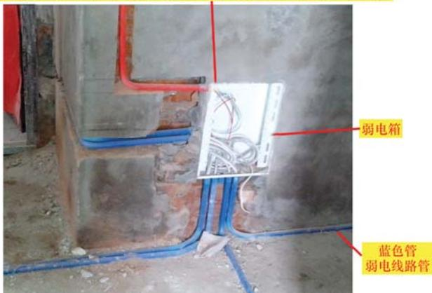
图 1-2 家装弱电系统图例
