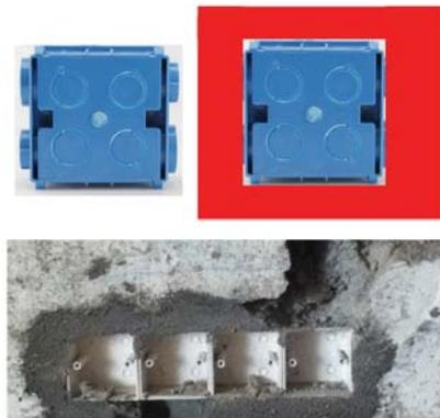
图 1-10 弱电暗盒开孔的宽度图例
