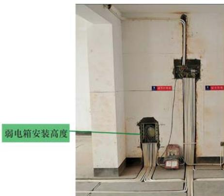
图 1-6 弱电箱安装高度图例
