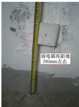
电视墙的弱电插座与强电插座的安装高度一样
