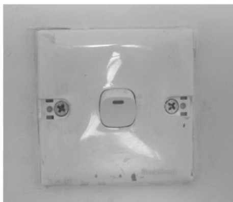
图 6-13 尚未安装护板的开关
