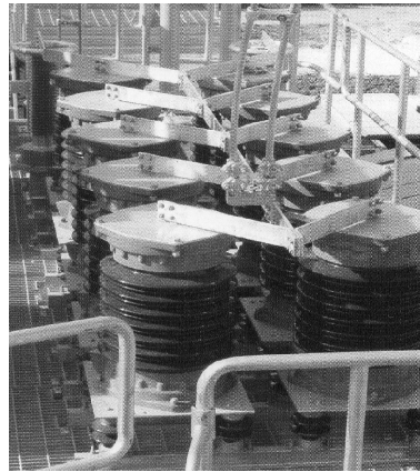
图 3-28 串并联后的避雷器组
