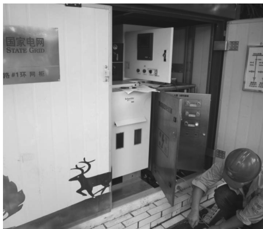
图 4-4 终端安装示意图
