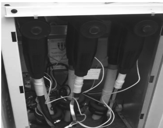
图4-6 二次回路接线示意图
