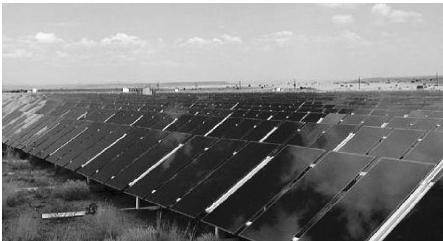
插图 7 实用规模的 CIGS 薄膜太阳电池
