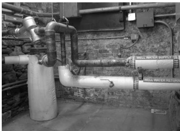
图 6-10 地热井的地上管道连接图
