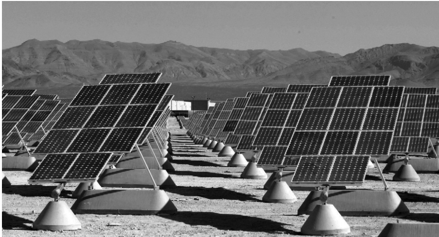
插图 6 单轴跟踪的晶体硅太阳电池
