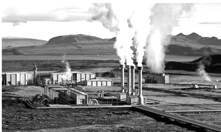
图 1-21 冰岛 Nesjavellir 地热发电站 (由于冰岛的火山较为集中，在利用地热能源方面具有优势。图中所示的是容量为 120MW 的 Nesjavellir 地热发电站)
