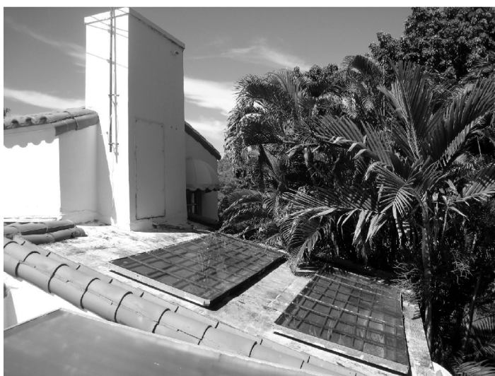
插图 14 19 世纪 20 年代生产并安装在迈阿密的全天候太阳能热水器 (太阳能热水器 (见 1.5.1, 11.2 和 11.3 节) 十分耐用。19 世纪 20 年代, 大约 40000 台全天候太阳能热水器安装在佛罗里达州。在恶劣天气气候下使用 80 年, 直到现在, 几千台仍正常工作。原因在于简单且没有运动部件。照片由作者于 2010 年 8 月拍摄于迈阿密)
