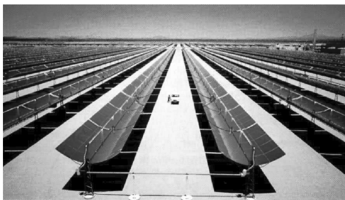
插图 11 位于加利福尼亚州 Kramer Junction 的抛物面槽式聚光器 (1984 年在位于加利福尼亚州 Mojave 沙漠中 Kramer Junction 建造的太阳能发电系统 (SEGS)。是世界上最大的太阳能发电系统，其总容量为 354MW，见 11.4 节)
