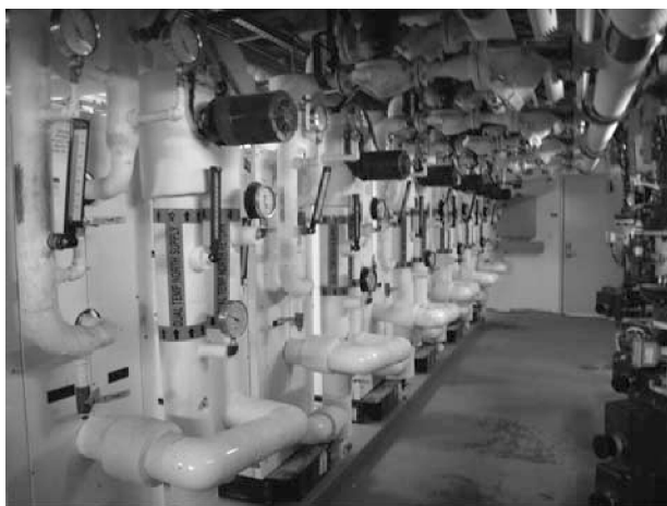
图 6-12 Knox Hall 地下室的热泵
