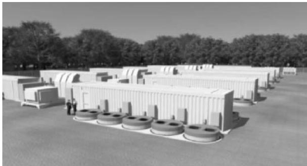
图 3-4 位于 PJM 的应用于频率调整的 20MW/5MWh 飞轮储能电站图（2011 年 12 月投产）
