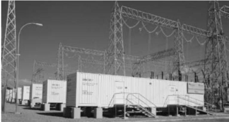
图 3-3 位于智利的应用于频率调整的 12MW/4MWh 储能电站图
