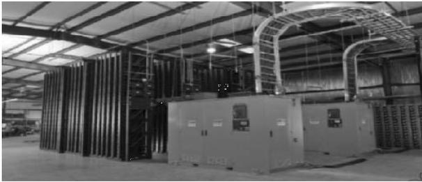
图 3-5 位于 HECO 的应用于频率调整的 Solid State Dry Cell 储能电站图
