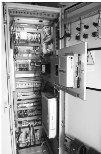
图 8-28 国产 Freqcon 主控柜布局图
