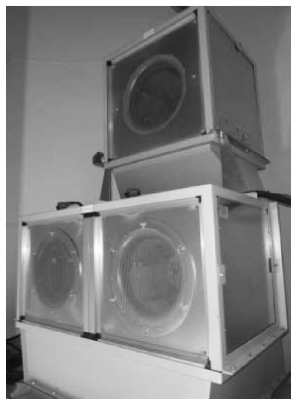
图 8-34 国产 IGBT 柜顶风扇
