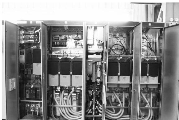
图 8-36 变流器柜布局图
