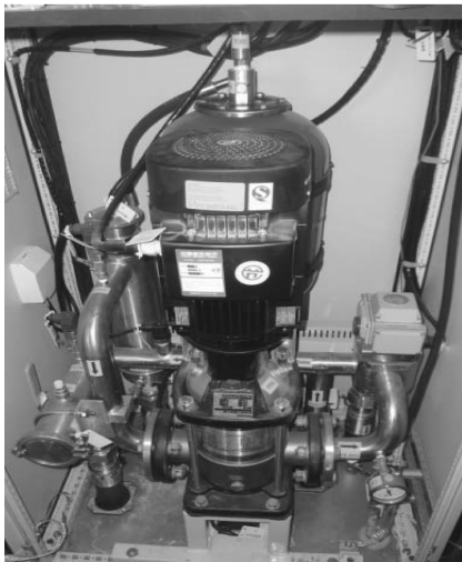
图 8-38 高澜水冷系统实物图
