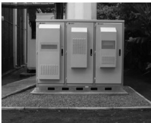
图 5-21 室外型 BBU 外观图
