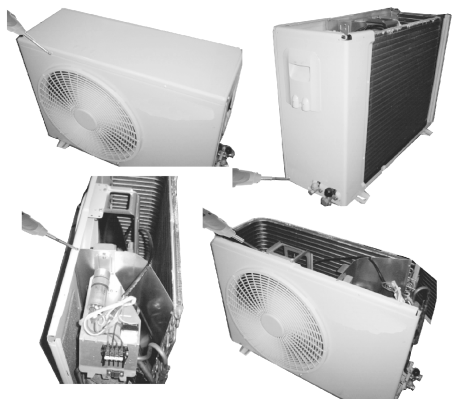
图 5-30 机盖及前面板的拆卸
