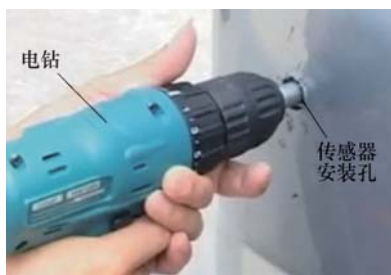
图 7-22 用电钻钻出 4 个传感器安装孔
