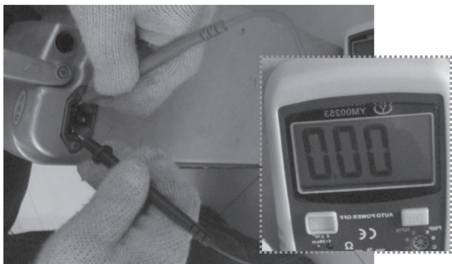
图 8-21 检测蓄电池充电插孔正、负极电压
