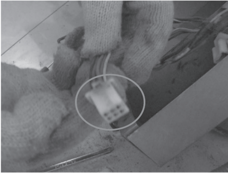
b) 拔掉霍尔元件接插线 图 5-13 拆解控制器
