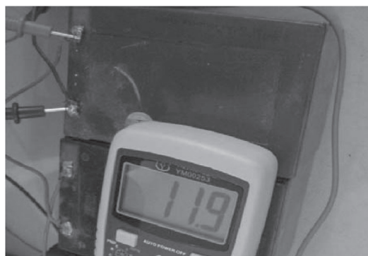
图 5-15 检测蓄电池单体电压差
