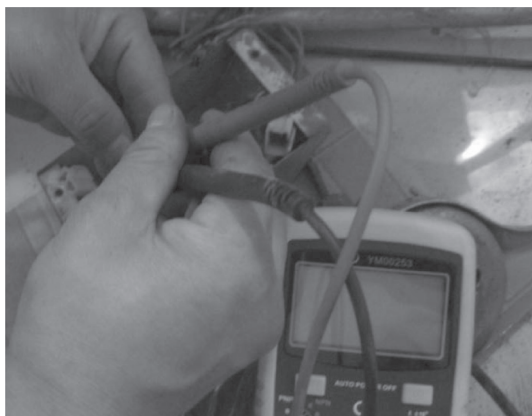
图 7-25 检测调速电源电压
