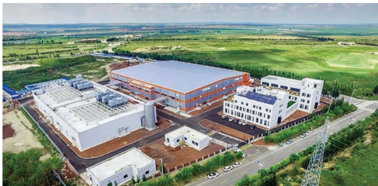
图 9-20 阿里张北数据中心一号园区外观
