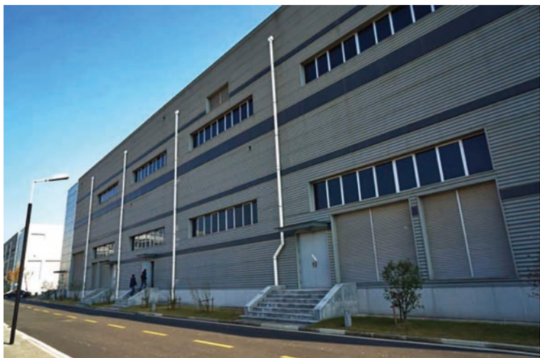
图 9-9 腾讯青浦数据中心外景
