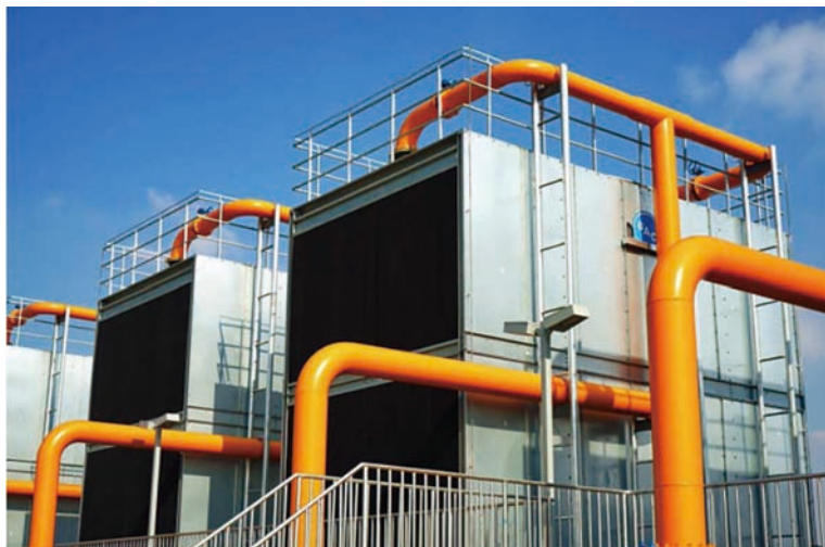
图 9-11 开式冷却塔
