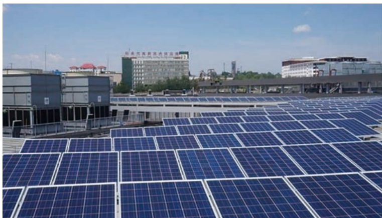
图 9-4 百度云计算(阳泉)中心楼顶的太阳电池板
