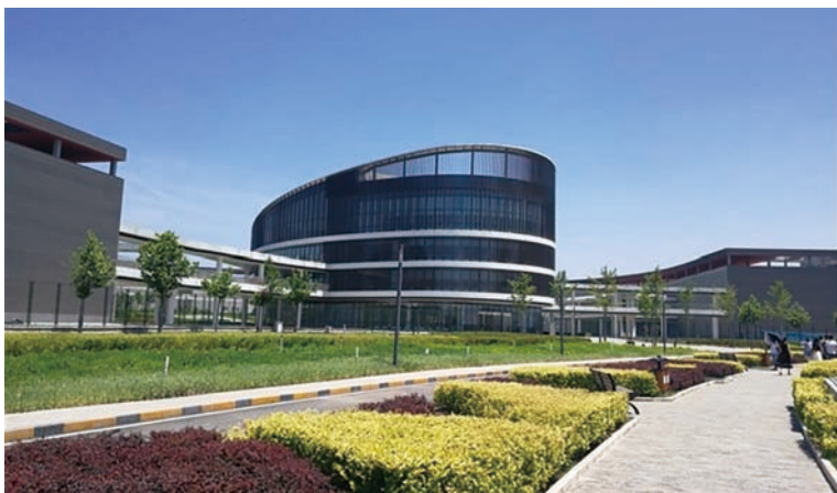
图 9-1 百度云计算（阳泉）中心监控中心 ECC 楼
