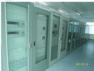
图 1.7 微型继电保护装置
