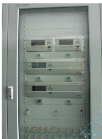
图 5.1 微型型自动重合闸装置
