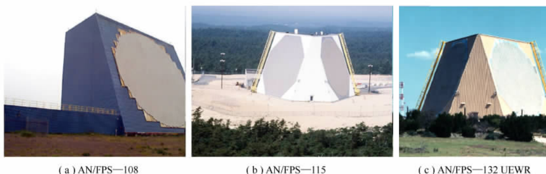
图 9.7 从 AN/FPS—108 雷达到 AN/FPS—132 UEWB 的发展过程
