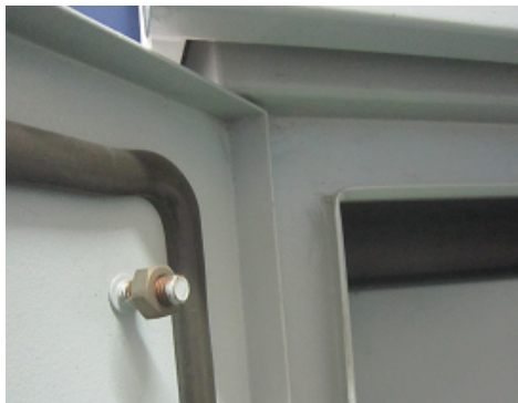
图 3.7 门缝隙的处理
