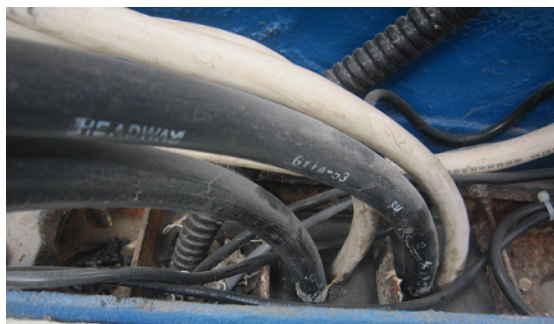
图 3.8 引线孔的处理 1
