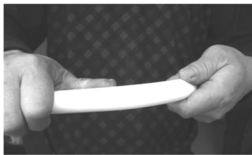
图 2-23 用力弯曲线管
