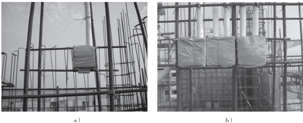
图 2-28 在立面墙壁上固定接线盒的方法
