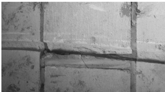
图 2-34 在二次结构墙体内切槽
