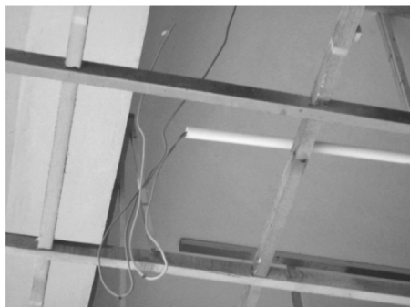
图 2-65 吊顶内的导线穿管后排放
