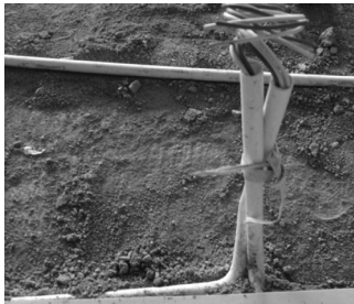
图 2-66 先埋设线管、穿好线
