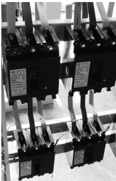
图 1-13 铝排的安装
