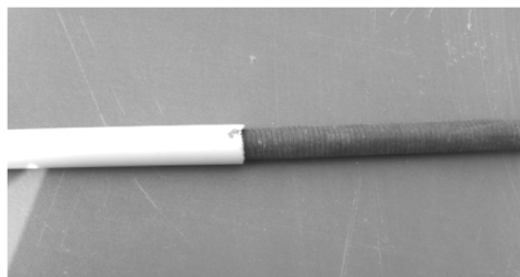
图 2-22 将硬弹簧插入线管内
