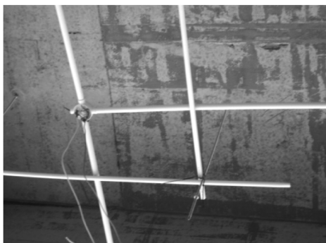
图 2-64 装修时线管应用拉丝固定
