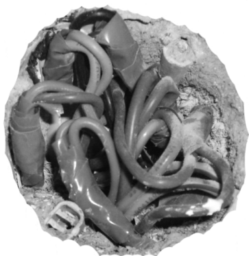
图 2-45 导线经中间接线盒穿线后连接
