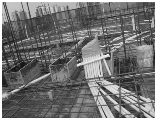
图 2-32 电井内线管的预埋
