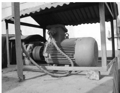
图 2-31 室外电动机应加防雨防晒棚
