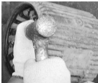
图 2-48 冷拆法拆除绕组
