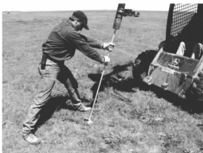
图 5-4 旋入式拉线地锚安装实例（来源：AWS Truepower）
