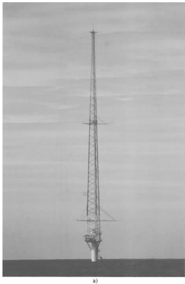
图 14-6 a) 北海风电项目海上监测塔；b) 北海风电项目测风塔图示。b 图左侧的横梁组装截面图说明加固横梁结构设计。（来源：Eecen PJ, Branlard E. The OWEZ Meteorological Mast. Analysis of mast-top displacements. NoordzeeWind report. Report OWEZ_R_121_mast_top_movement. pdf)
