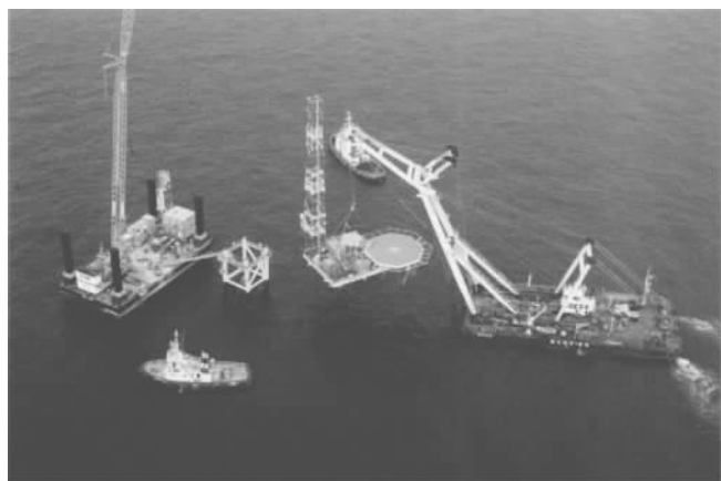
图 14-7 使用自升式驳船（左侧）和起重驳船（右侧）安装 FINO 1 海上研究平台。（来源：FINO 1 research platform, Copyright Bilfinger Berger Civil, Germany）
